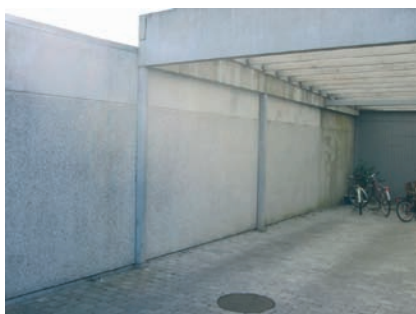
Figur 1. Galvaniseret, lukket, bærende stolpe nedstøbt i beton.
